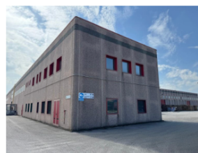
L'impianto di Gurit Italia a Carmignano di Brenta (PD)
